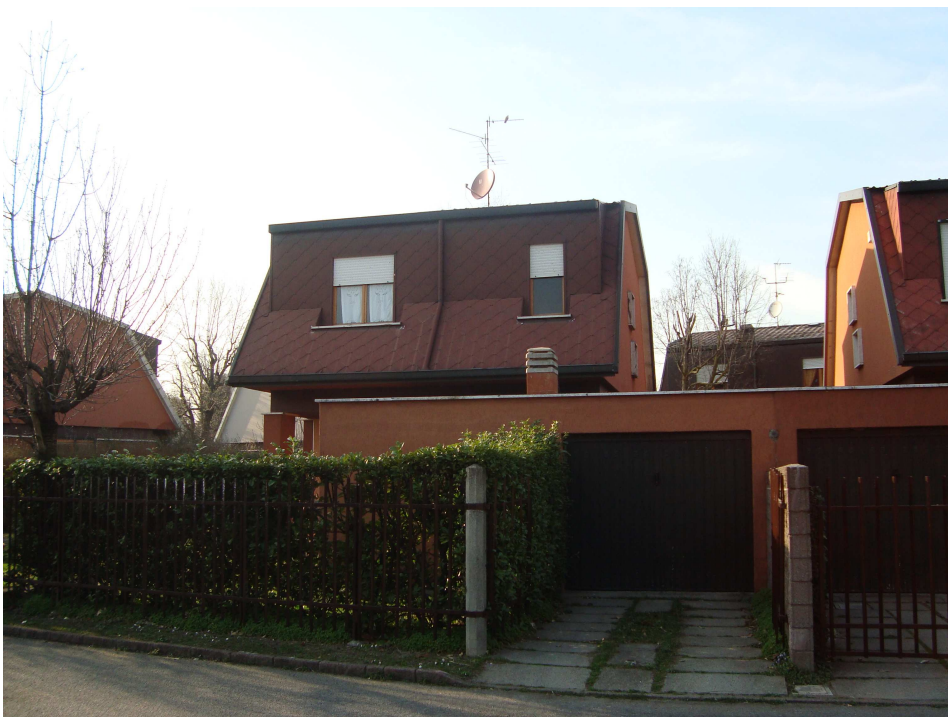
Fig. 4 – Villaggio con case a fungo di Via Campo Gallo n. 21
